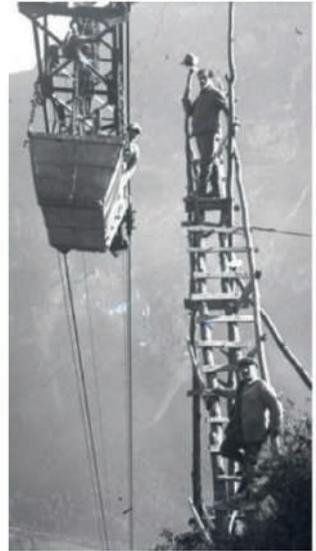
**Pour la construction de la centrale de Bâton, un blondin de 1600 mètres (grue de service sur câble) fut installé pour le montage de la conduite.**
